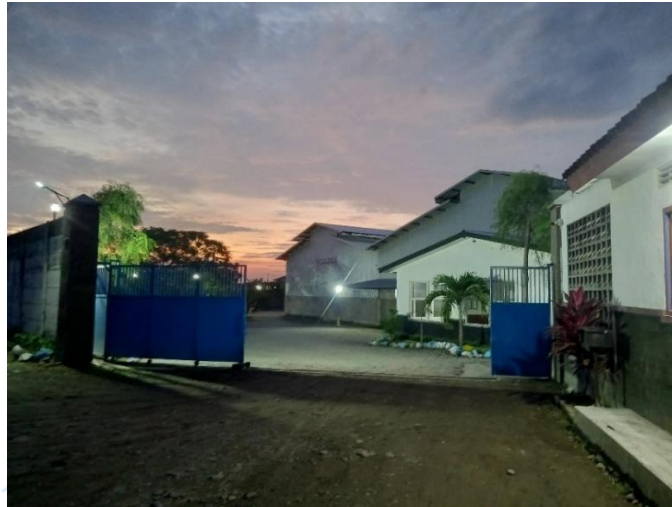
Gambar 2. Bangunan PT Sari Unggul Makmur Tampak Depan (Sumber: penulis)
