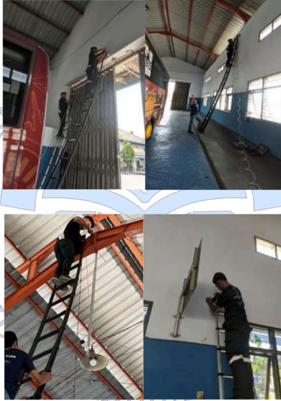
Lampiran 1. Pemasangan CCTV
