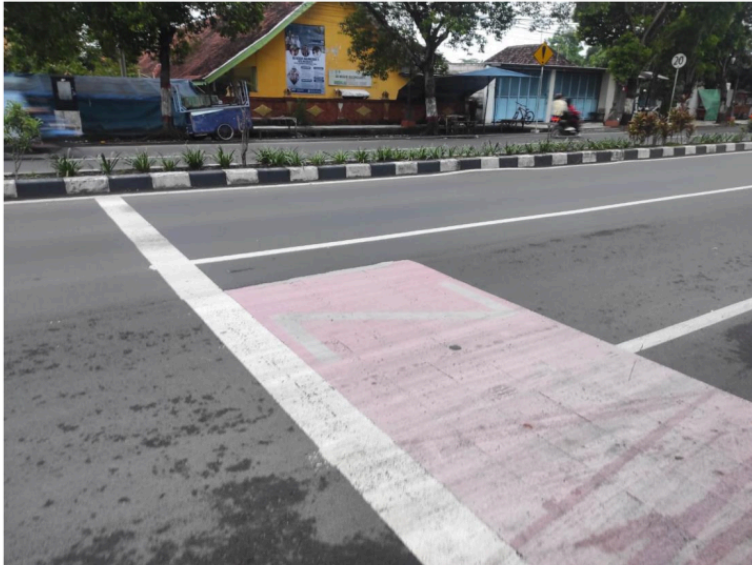
Gambar 22. Kondisi Marka Zoss
