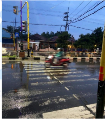
Gambar 20. Kondisi Zebra Cross
