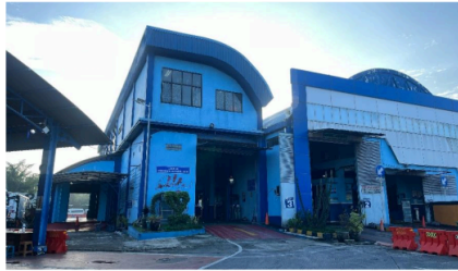
Gambar 37. Lajur 3 sebagai tempat penerapan pemasangan panel surya
