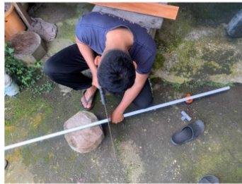
Gambar 22. Pemotongan pipa
