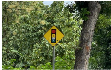
Gambar 5. 10 Kondisi Rambu Peringatan APILL
