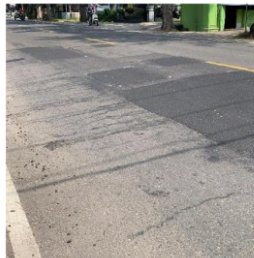
Gambar 2. 2 Kondisi Eksisting Ruas Jalan D.I Panjaitan
