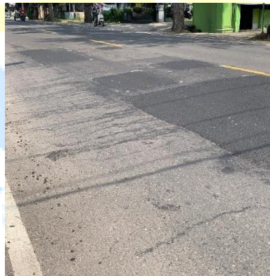
Gambar 2. 2 Kondisi Eksisting Ruas Jalan D.I Panjaitan
