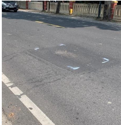
Gambar 2. 3 Kondisi Eksisting Ruas Jalan D.I Panjaitan
