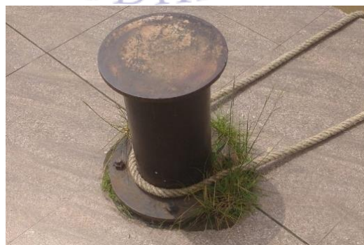
Gambar 4. Bolder yang ada di Dermaga 16 Ilir
