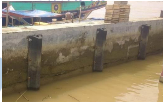
Gambar 5. Fender yang ada di Dermaga 16 Ilir
