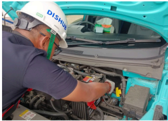
Gambar 34. Memeriksa kabel listrik tegangan rendah
