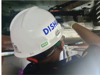
Gambar 41. Memeriksa pemasangan kabel dari baterai ke konverter dan kontroler
