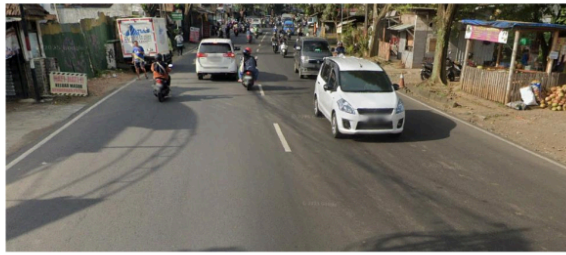
Gambar 13 Visualisasi Marka Pada Sta 6 Ruas Jalan Sudanco Supriadi
