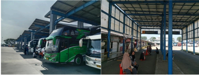
Gambar 17. Layanan Fasilitas Keselamatan Jalan Pada Terminal
