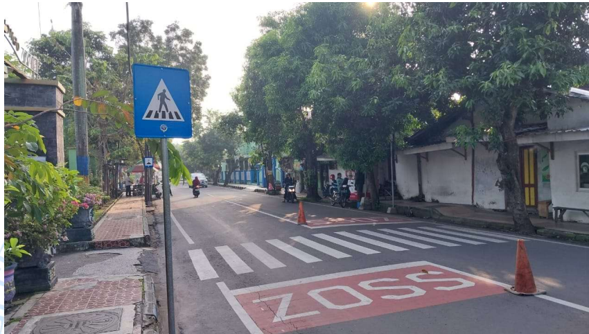
Gambar 1 Kondisi eksisting ZoSS SD N 01 Winongo
