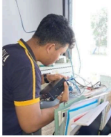
Lampiran 19. Dokumentasi pemasangan amplifier
