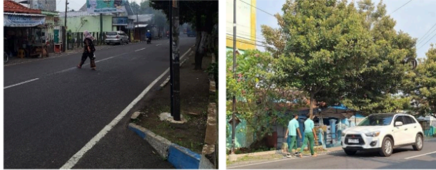
Gambar 15. Kondisi Eksisting Sisi Timur
