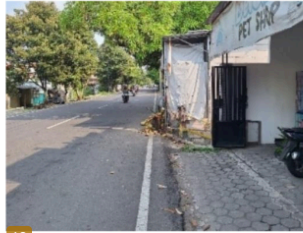
18 Gambar 14. Kondisi Eksisting Sisi Barat
