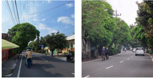
Gambar 12. Kondisi Eksisting Kurang Tersedianya Bahu Jalan
