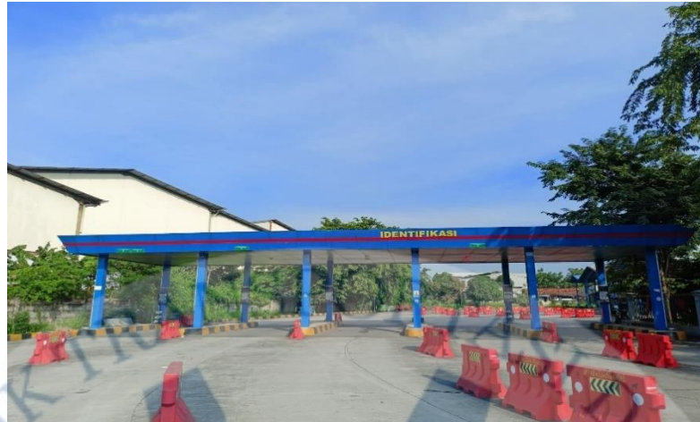
Gambar 2. Gedung Identifikasi Kendaraan
